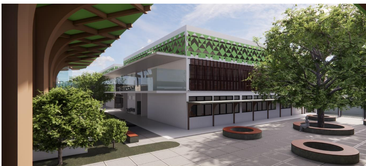
Imagem 14 – Vista do Bloco Educacional I
