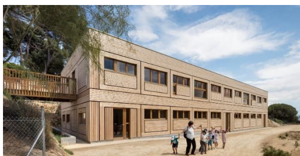
Imagem 3 – Fachada do novo jardim de infância e edifício dos espaços comuns.
